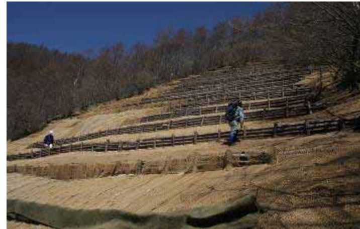
やがて土に還るヤシネットで土砂を止め、 周囲からの種の実生を待ちます。
