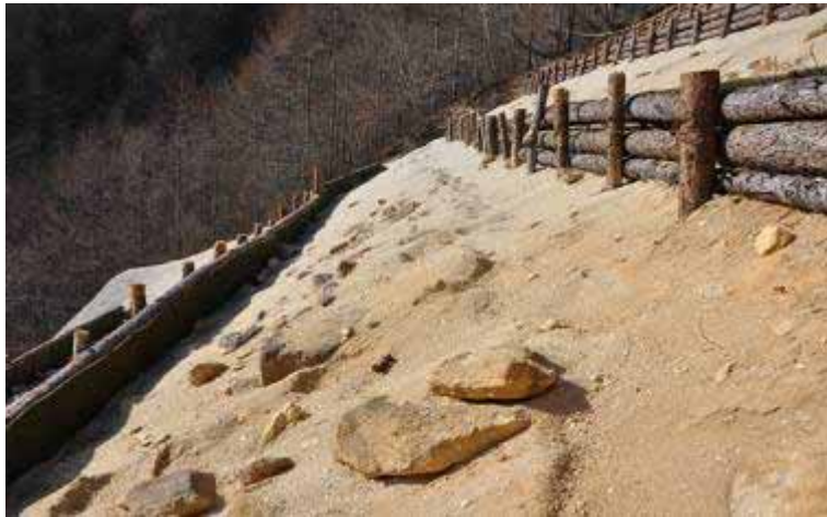
周辺のカラマツの間伐材で、 まず階段状の土留め工をほどこし、
